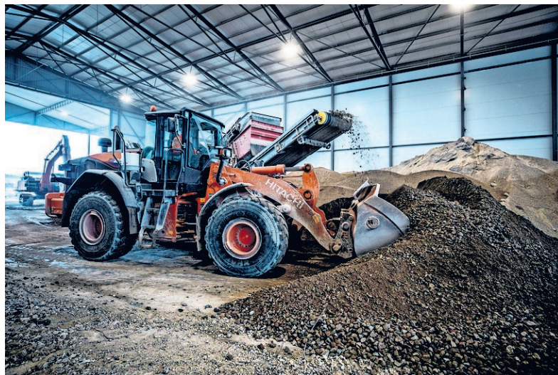
Het oude beton wordt gebroken en gescheiden.
