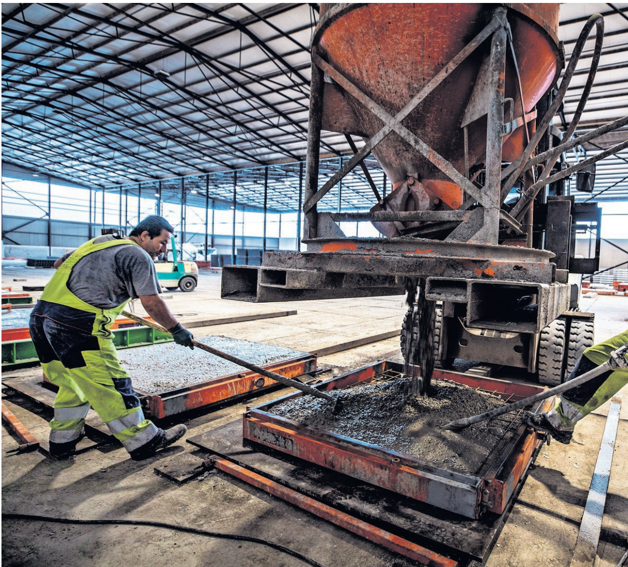
Medewerkers van Smart Circular Products in Zaandam gieten circulair beton in platen voor onder meer
